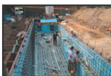
Murs de soutènement
