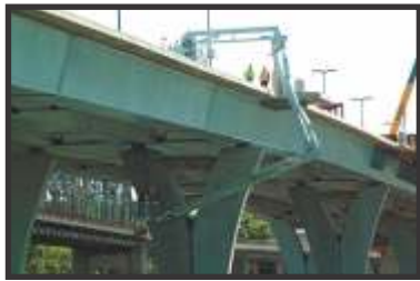
Bords du pont
